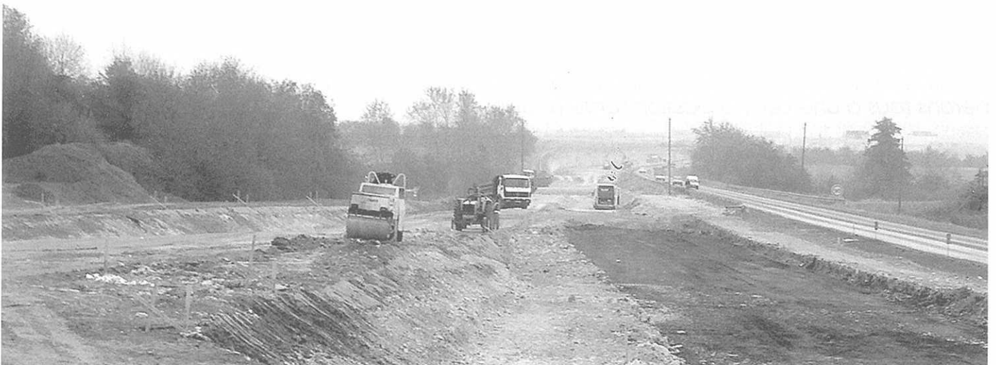
La 2x2 voies en cours de réalisation. Elle sera reliée par des bretelles.
