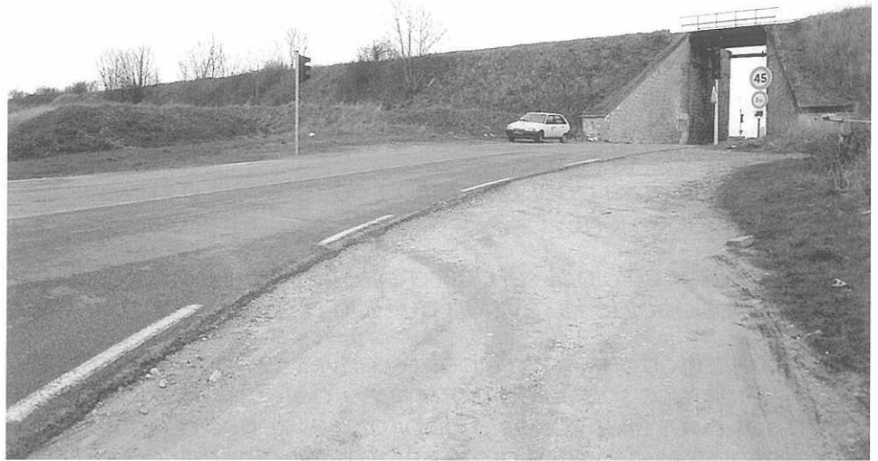
Ce pont abattu, un ouvrage fera jonction entre le Bourg et le Plateau. Un trottoir de 1,50 m servira aux cyclistes et piétons.
