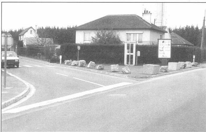
A la demande des riverains, la modification du carrefour de la rue de la Liberté et rue des Cités est réalisée ; un arrêté municipal interdit de tourner à droite venant de Colombelles.
