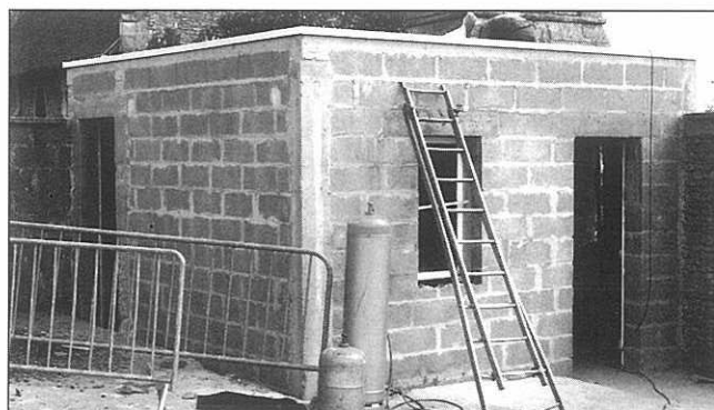
Construction d'un local pour le gardien du cimetière
