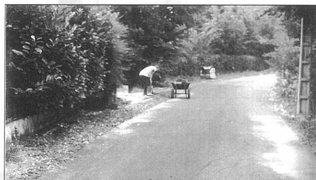
Rue du Marais construction complète de la voirie
