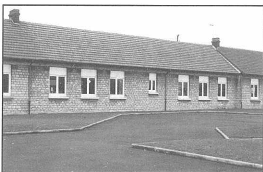
La deuxième tranche des menuiseries extérieures en P.V.C. est totalement terminée.
