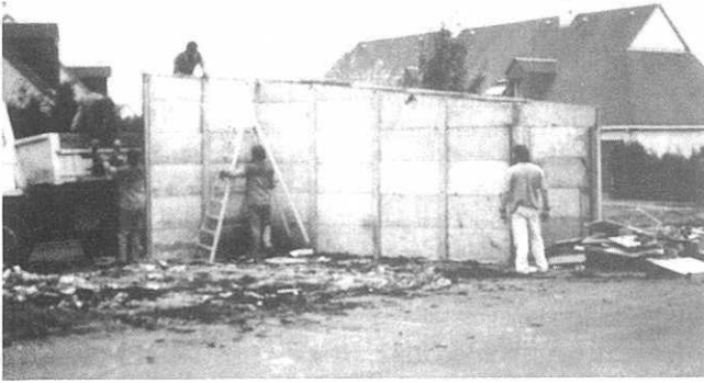
Récupération de garages par la ville de Giberville(ceux-ci seront remontés sur le stade pour stockage de matériel de sports)
