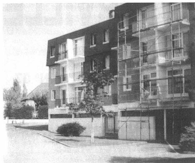
Travaux de rénovation du RPA
