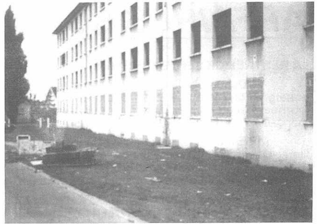
La société HLM Foyer Normand,procède actuellement à l'appel d'offres pour démolition du Lopofa
