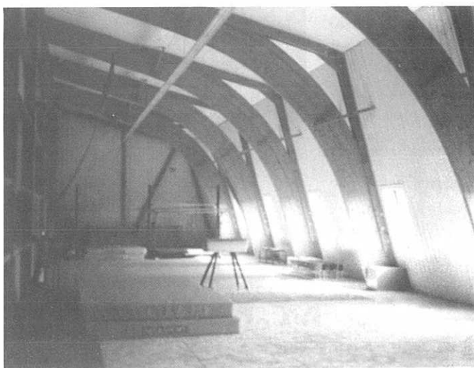
Isolation de la mezzanine Salle Pierre Cousin
