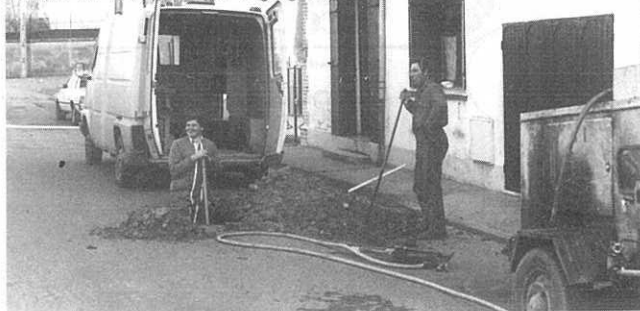
Travaux sur réseau (suite à engorgement)
