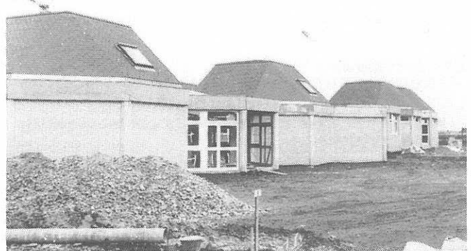
Façade du Groupe Scolaire
