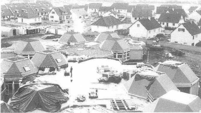
Vue aérienne du Groupe Scolaire en construction
