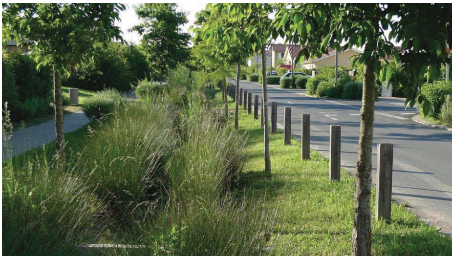
Photo d'ambiance de voirie bordée par une noue plantée
